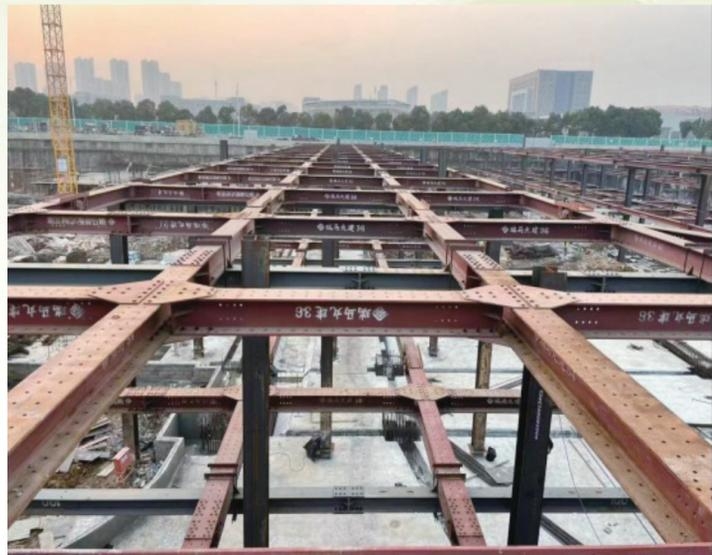
及地下人防工程项目开工,其深大基坑支护工程在国内首次采用了HCU工法桩+装配式型钢支撑体系技术,该技术从围护到支撑真正实现了全钢结构,全绿色施工,所有材料可实现全回收、全循环使用。
